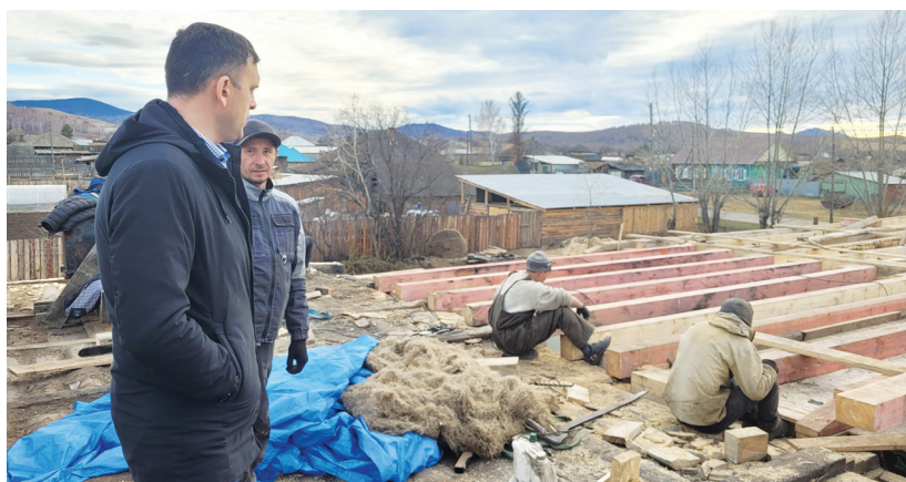
Ремонтно-восстановительные работы продолжаются
